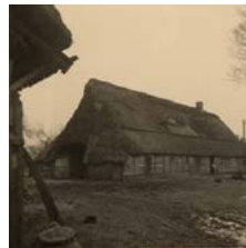
Das Haupthaus, das als erstes abgebrochen werden sollte
